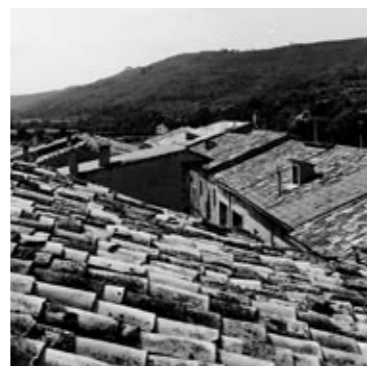
Vista aèria del carrer de Vilanova i plaça de Giralt
