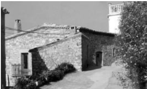
Les Corts de Cal Farrés. Segons l'actual normativa és un allotjament rural independent. Es tracta d'una edificació situada en un petit nucli de població (Alerý) de menys de 25 habitants.
