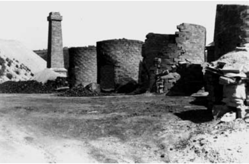
Forns del ciment, anys 70
