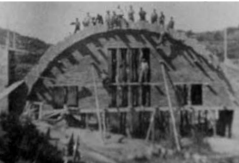
Construcció del pont. 1936
