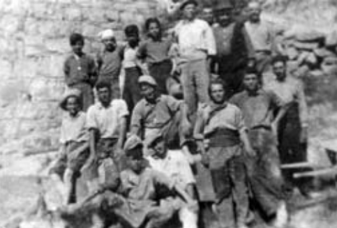
L'equip que va construir el pont. 1938
