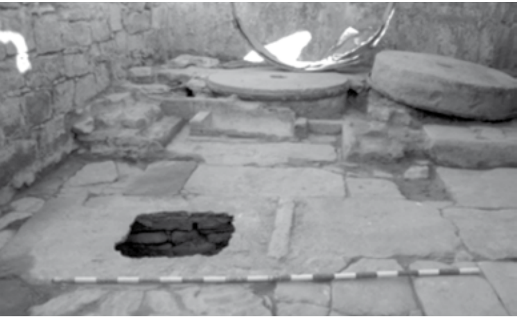
Primer pla detall de l'accés al carcabà. Segon pla la mola sotana in situ i la mola volandera
