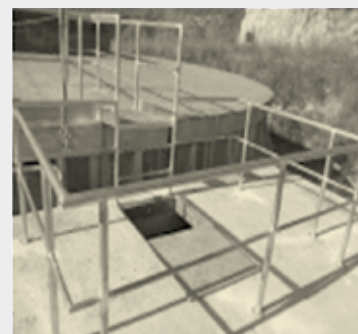
Accés a coberta - Boca d'home
