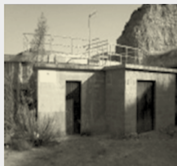
Obres dipòsit, vista general
