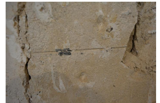
Especejament en el revestiment beix picotejat
