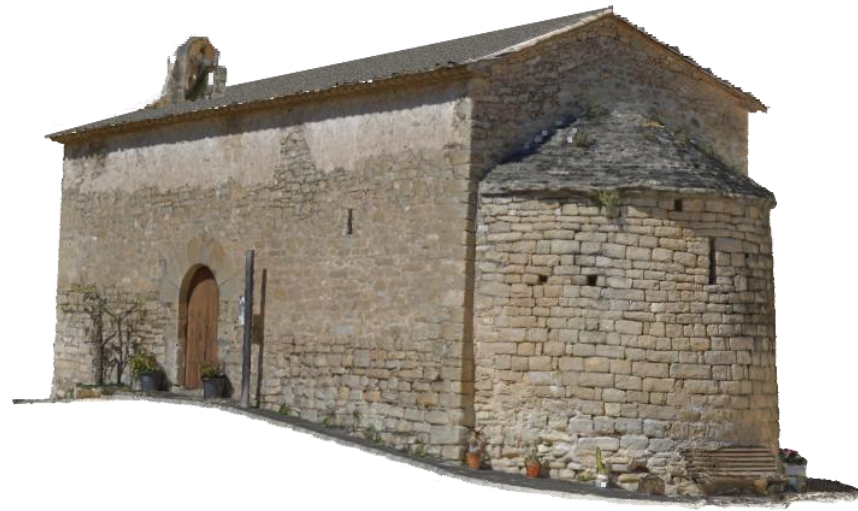
Model 3D de l'estat actual de l'església per fotogrametria
