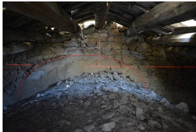
Traces de l'antiga volta romànica visibles al sotacoberta
