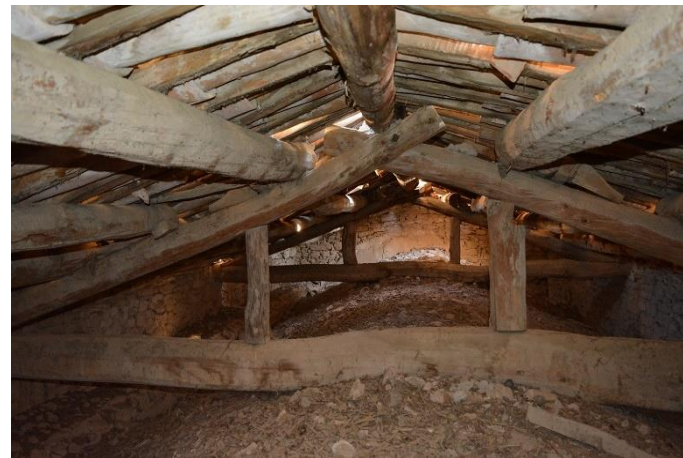
Vistes sota coberta, per sobre de l'extradós volta actual
