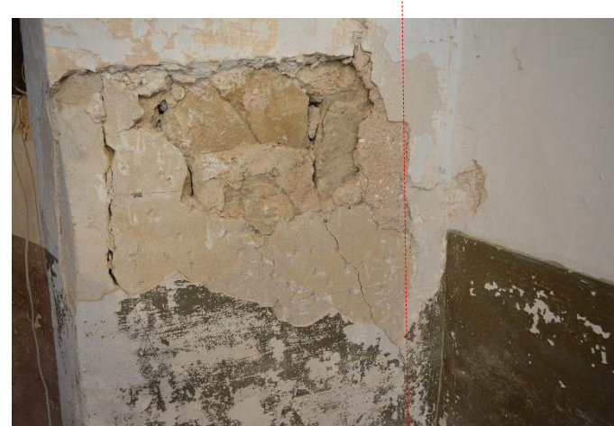
Revestiment beix picotejat que no arriba a la cantoanda entre el paramnt sud i l'est, indicant que el mur sud és posterior i més prim que l'original
