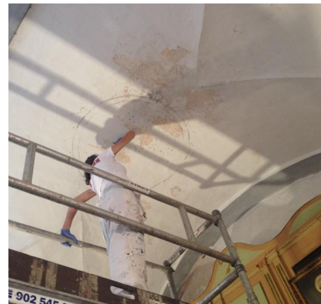
Revestiment beix picotejat que no arriba a la cantoanda entre el paramnt sud i l'est, indicant que el mur sud és posterior i més prim que l'original
