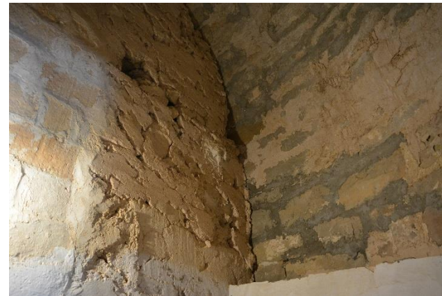
Mur de tancament absis, sense traves amb la fàbrica romànica original
