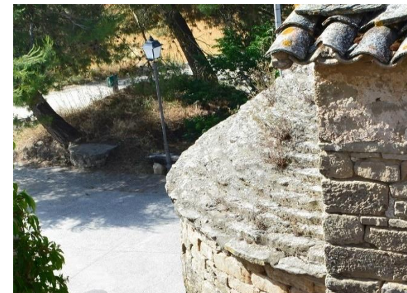
Coberta absis lloses de pedra
