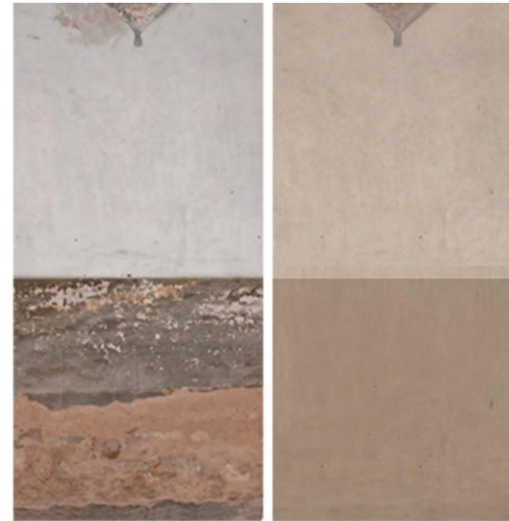
Estat actual i proposta restauració revestiments paraments
