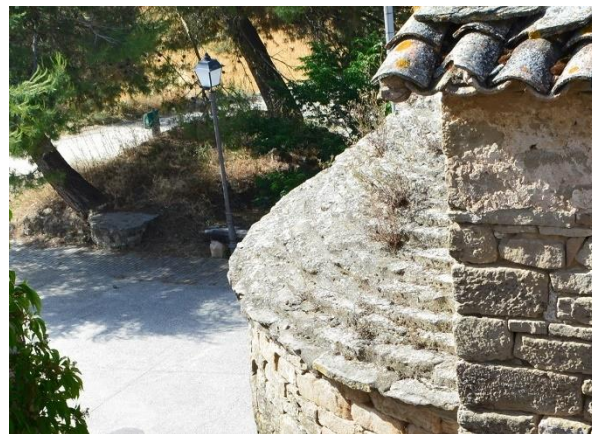
Coberta absis lloses de pedra
