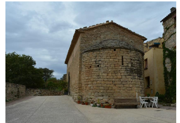
Vista actual façana est
