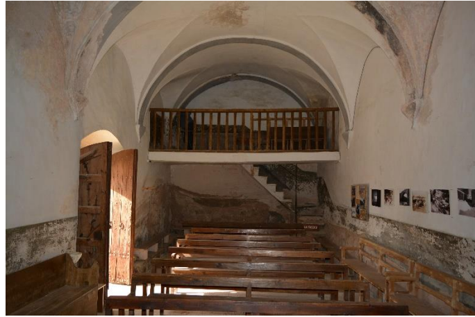
Vista actual interior
