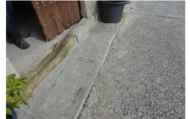
Marxapeu d'entrada, molt degradat
