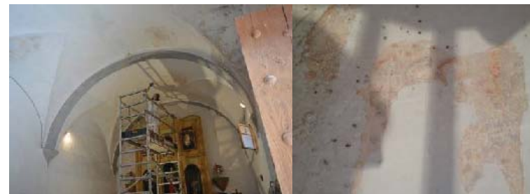
Realització de la cala núm. 1
