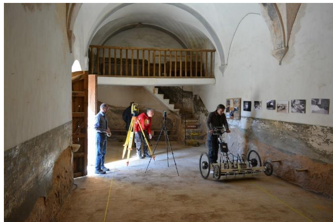
Prospecció amb georadar a l'interior
