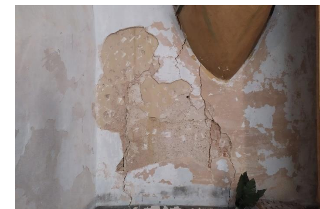
Parament interior est, en el punt de contacte entre la fàbrica original i el mur de tancament absis
