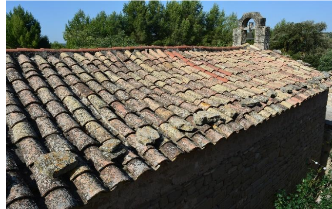
Coberta nau de teula àrab
