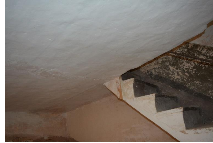
Intradós forjat, cor, amb esquerda longitudinal
