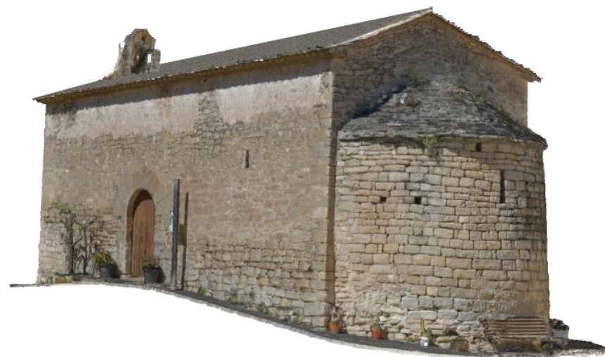
Model 3D de l'estat actual de l'església per fotogrametria
