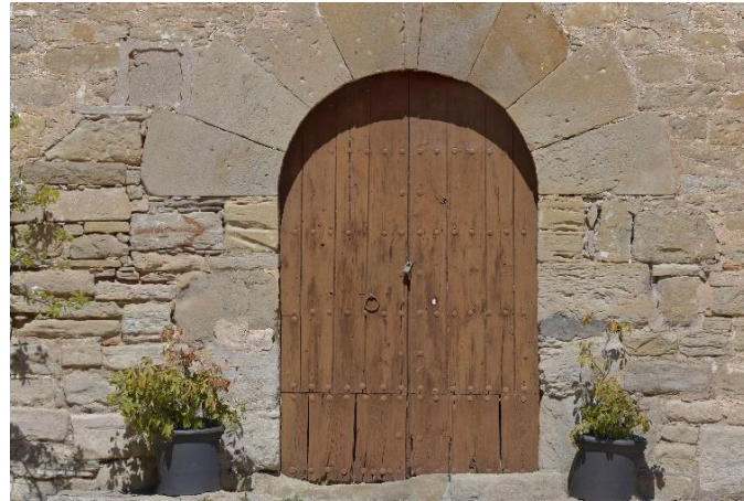
Porta façana sud P1
