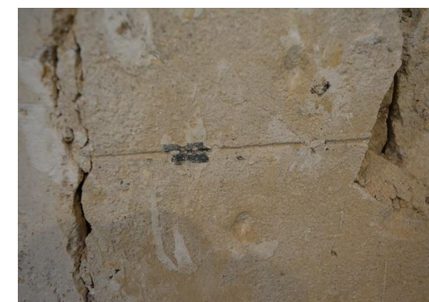
Especejament en el revestiment beix picotejat
