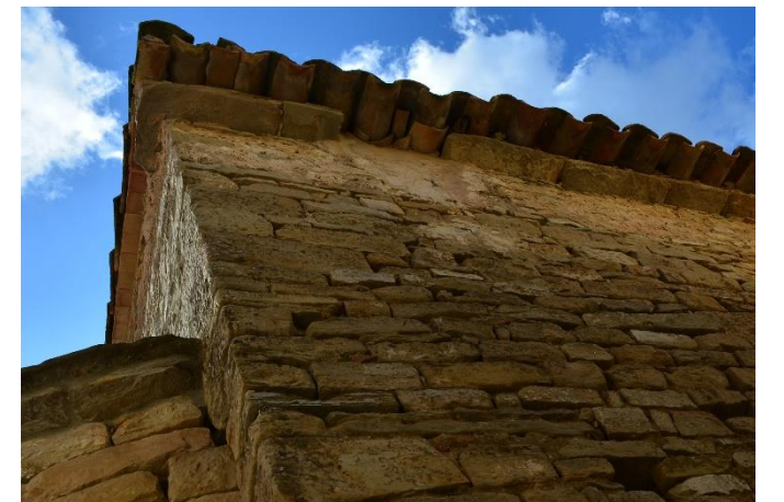
Ràfec façana nord amb lloses de pedra i teula
