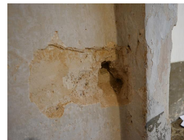
Trobada mur perimetral de l'absis i tancament
