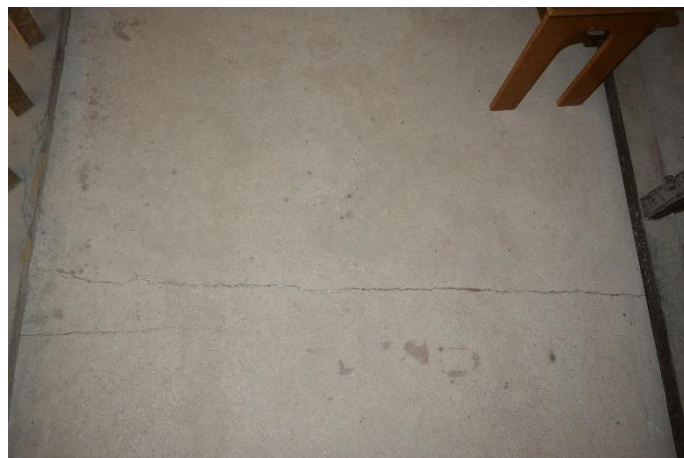
Extradós forjat, cor, amb esquerda longitudinal
