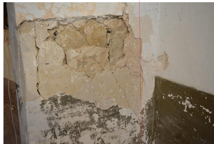
Revestiment beix picotejat que no arriba a la cantoanda entre el parament sud i l'est, indicant que el mur sud és posterior i més prim que l'original
