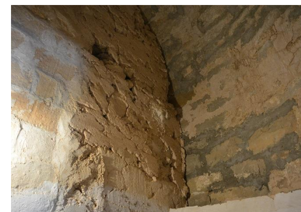
Mur de tancament absis, sense traves amb la fàbrica romànica original
