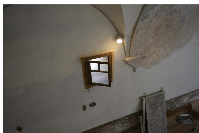
Finestra F1 des de l'interior de la nau
