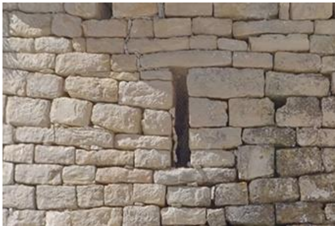
Finestra façana est F2
