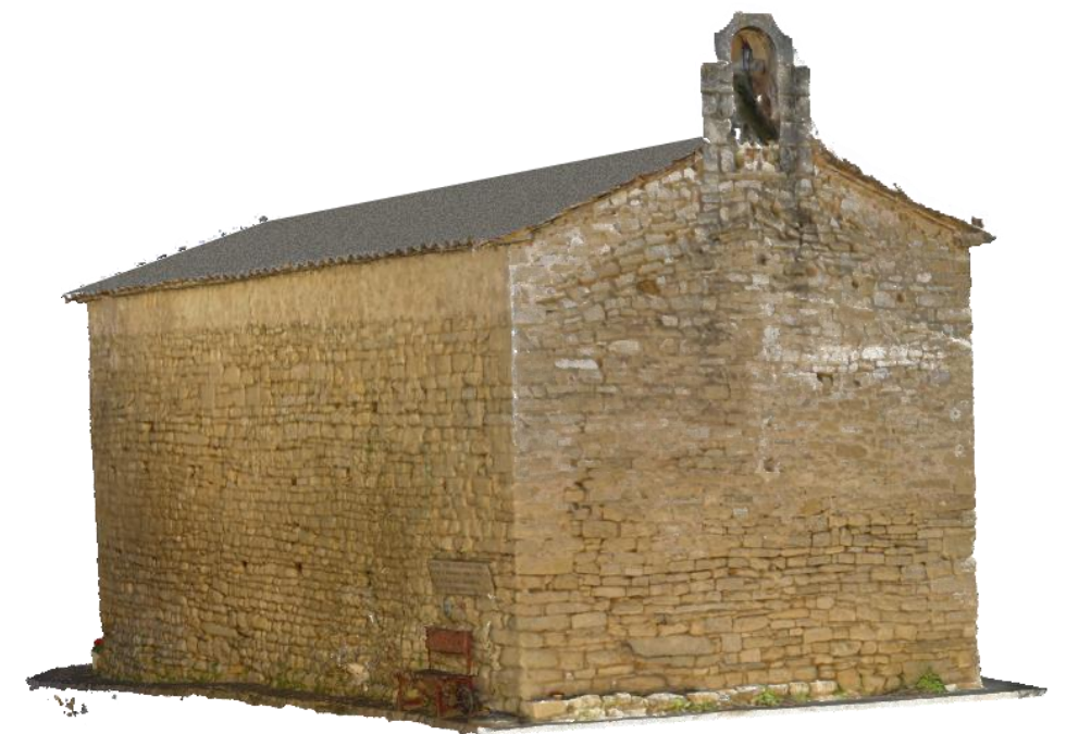
Model 3D de l'estat actual de l'església per fotogrametria
