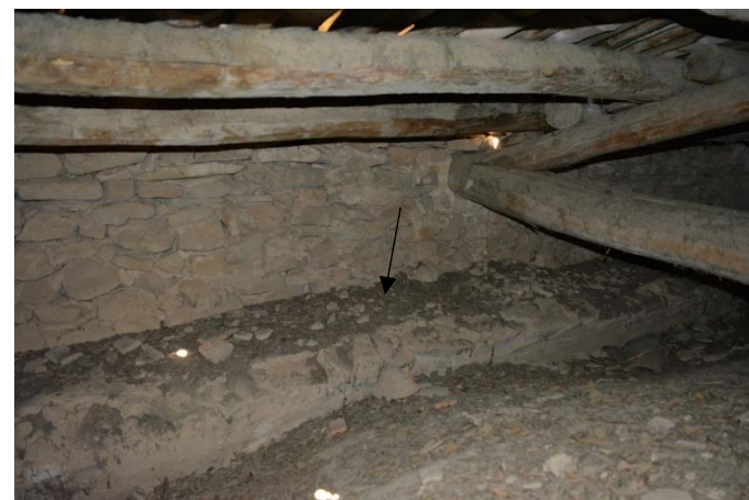
Restes de l'arrencada de la volta de pedra original
