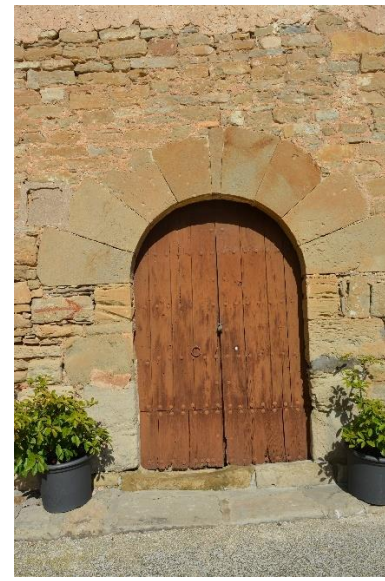
Vista actual porta adovellada entrada
