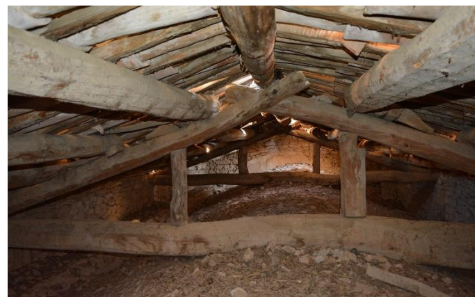
Vistes sota coberta, per sobre de l'extradós volta actual Marià cubí 66 local 1 \\\ Barcelona 08006 \\\ T: 932 405 810 www.matters.cat \\\ info@matters.cat
