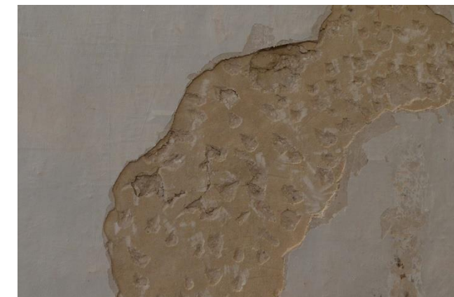
Cala deixant a la vista el revestiment beix picotejat
